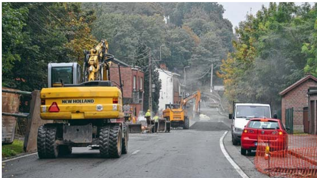
Les ouvriers ont dû faire face à deux imprévus. ■ D.M.
